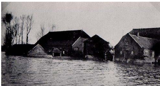
Solitair boerderij in het buitengebied tijdens hoogwater in 1924. Het gebouwencomplex ligt op een terpachtige verhoging, waardoor alleen de kelder onderliep.
